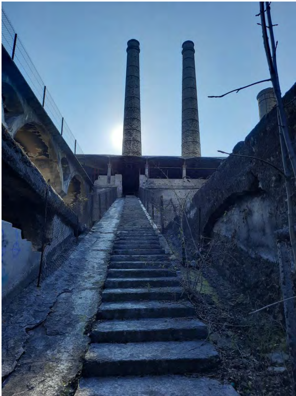
Cementeria Pesenti, Alzano Lombardo (1833–1966). Forni per la cottura delle marne.
