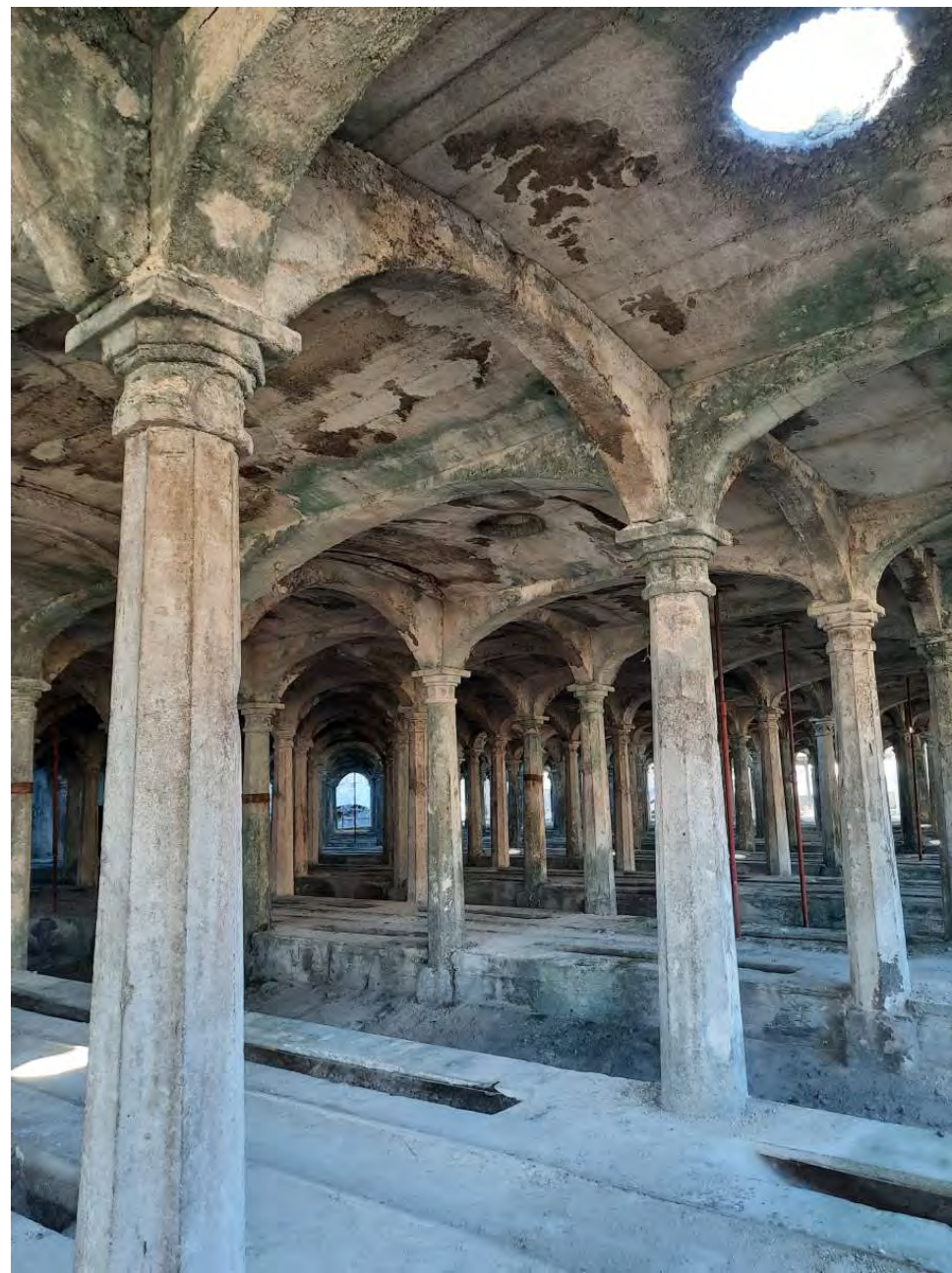
Cementeria Pesenti, Alzano Lombardo (1833–1966). Primi esperimenti su solai sottili in cemento armato.
